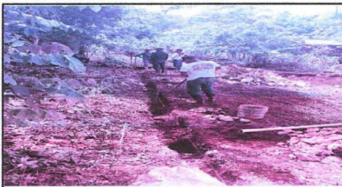
Foto 3: se abrio un poco la tierra por donde pasara la malla
